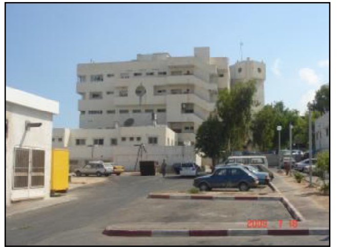
المدخل الجنوبي لا يوجد به مواقف خاصة لذوي الاحتياجات الخاصة
