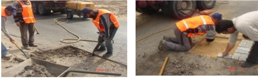
شكل(3): توضح أعمال إصلاح الطرق
