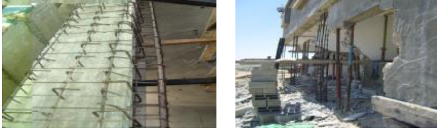
صورة توضح أعمال ترميم الأعمدة
