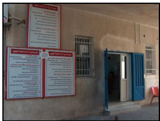
المدخل الثانوي لمبنى الخدمات العامة بدون منحدرات
