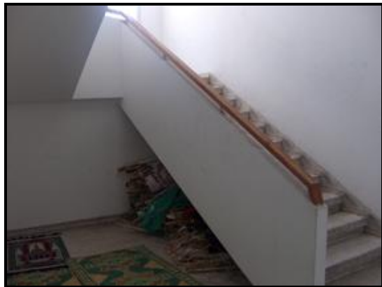
بيت الدرج في مبنى الخدمات بدون مصعد
