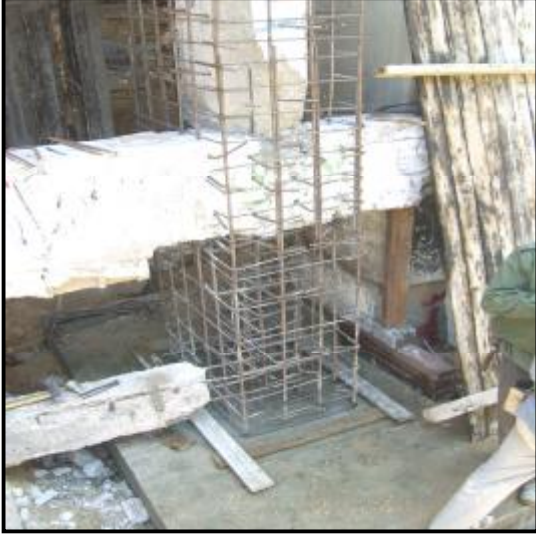
صورة توضح القاعدة والرقبة اثناء الترميم
