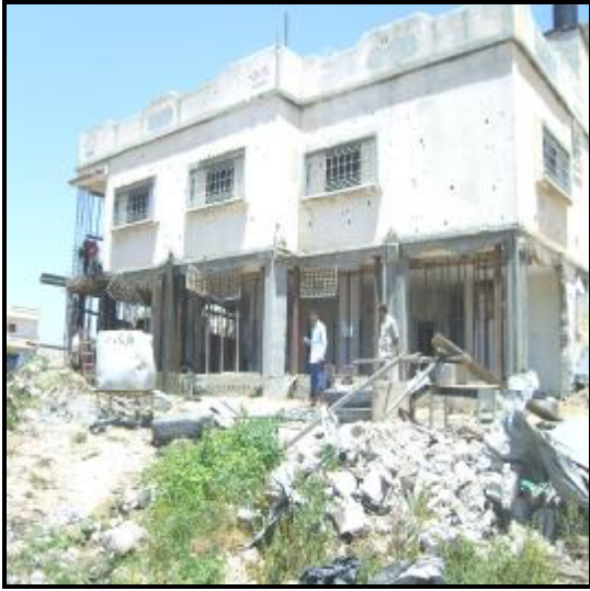
صورة توضح الأعمدة بعد الترميم
