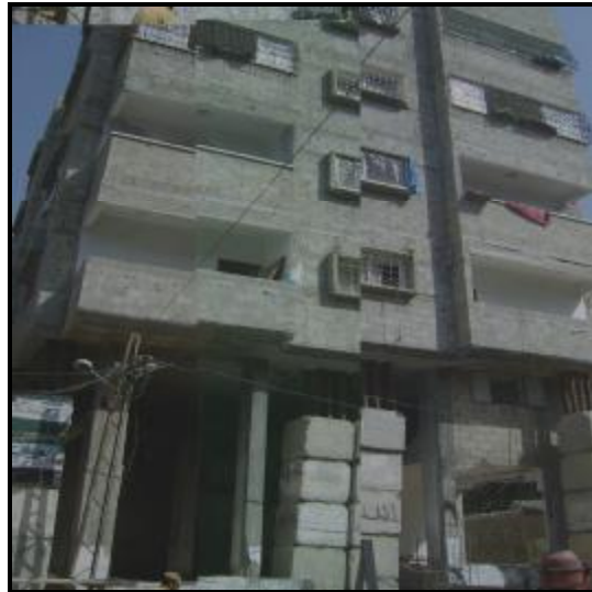
صورة توضح تدعيم مبنى مكون من خمسة طوابق في مخيم الشاطئ
